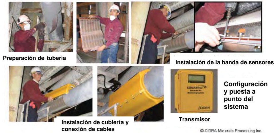
Figura 1. Procedimiento de instalación (desde la parte superior izquierda hasta la parte inferior derecha: preparación de la tubería por medio de limpieza y limado liviano; instalación de la flexible banda de sensores de bajo peso; instalación de la cubierta del sensor; y conexión de la cubierta del sensor al transmisor a través de un cable impermeable
